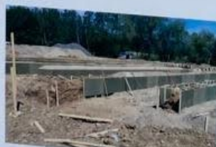
Výstavba nádrží (květen - červen 2019)
