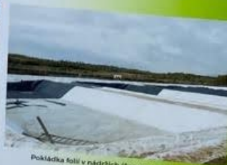
Pokládka fólie v nádržích (červenec - září 2019)
